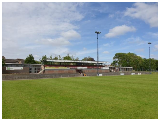
Figuur 4: De onderzoekslocatie gezien vanuit noordoostelijke richting, met van links naar rechts de kleedlokalen, de tribune en de kantine
