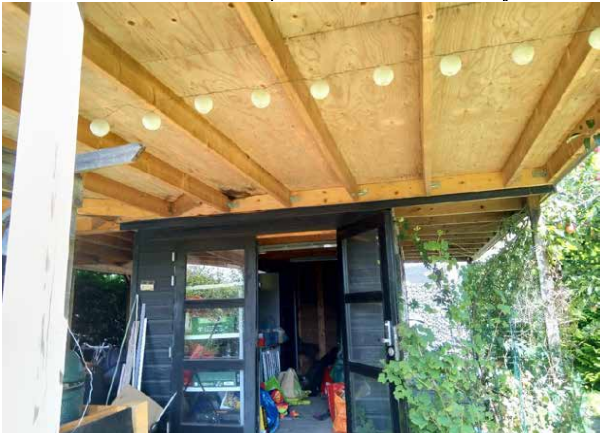
Foto 6: De overkapping met opslagschuur aan de westzijde van de onderzoekslocatie.
