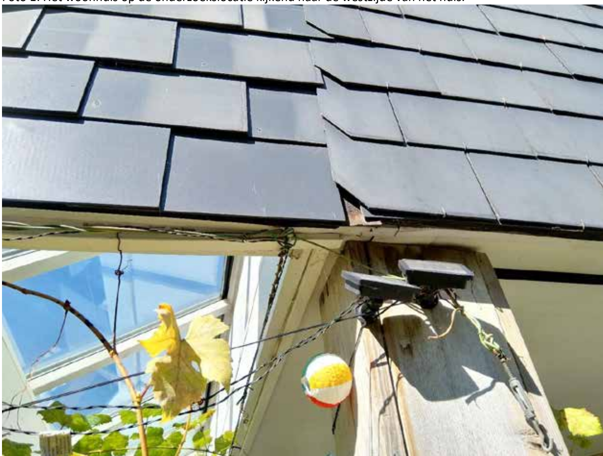
Foto 2: De leistenen gevelbekleding aan de oostzijde van het woonhuis met een opening tussen de leistenen.
