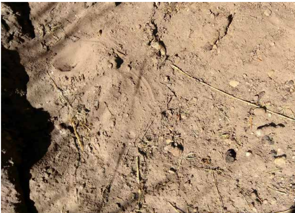
Foto 7: Kattenfecaliën aan de zuidwestzijde onder de overkapping.
