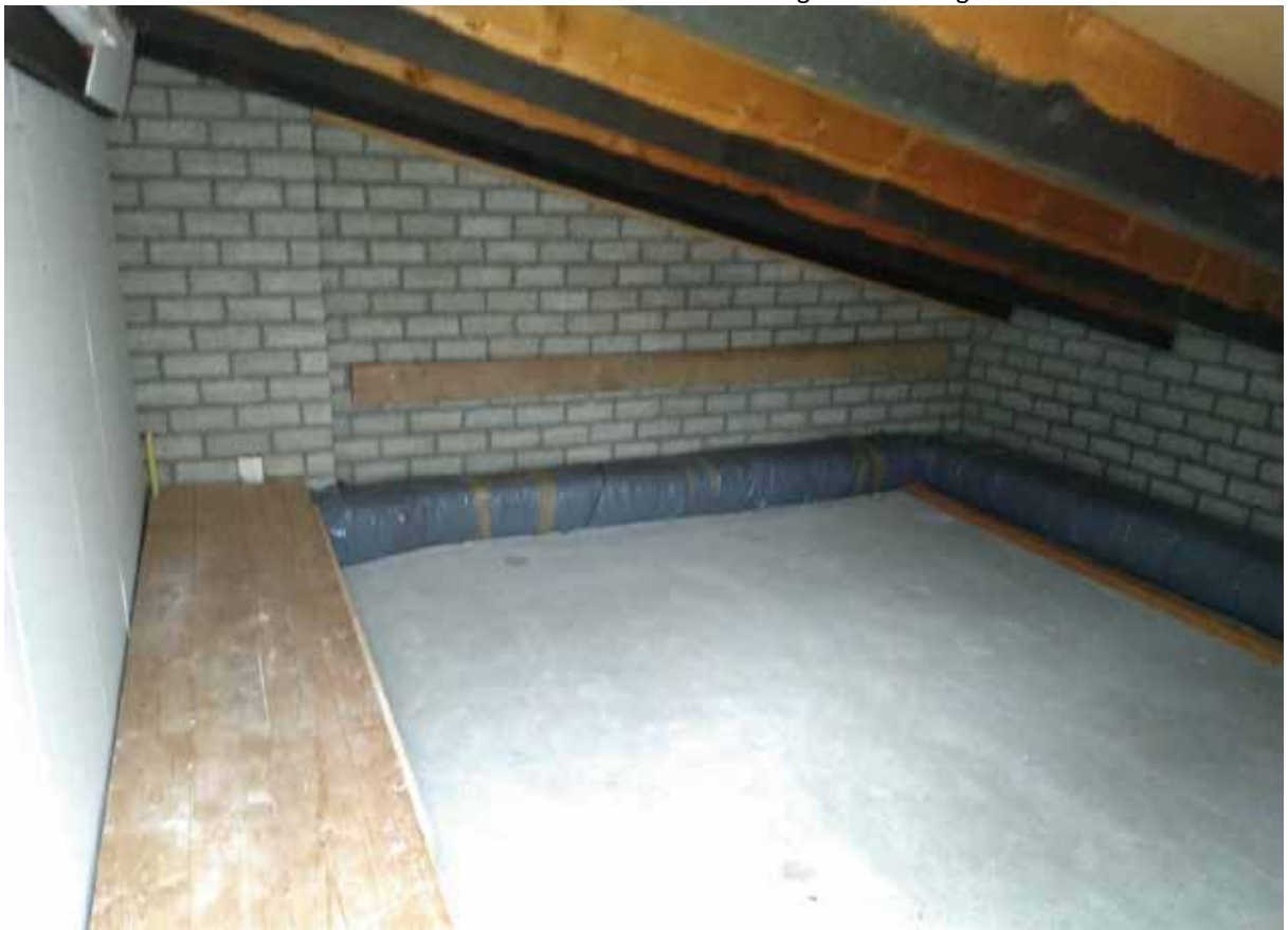
Foto 4: Overzichtsfoto van de zolder aan de oostzijde van het woonhuis.
