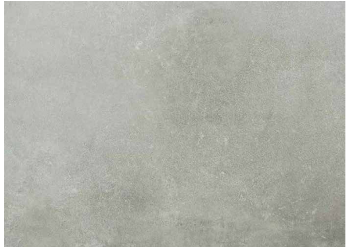
Betonlookstucwerk / prefab betonelementen
