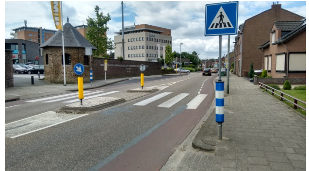
Oversteekvoorziening met middengeleider: zonder VOP (links) en met VOP en blauw witte koker (rechts)
