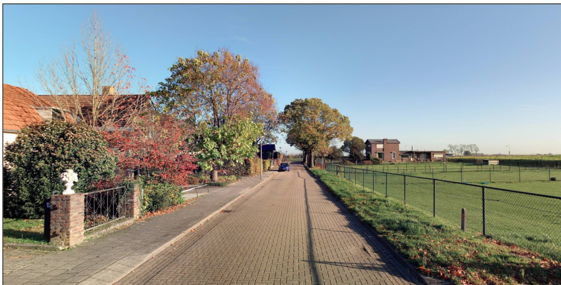
Afbeelding 3 Wegdekverharding op de Heihofweg te Landgraaf
