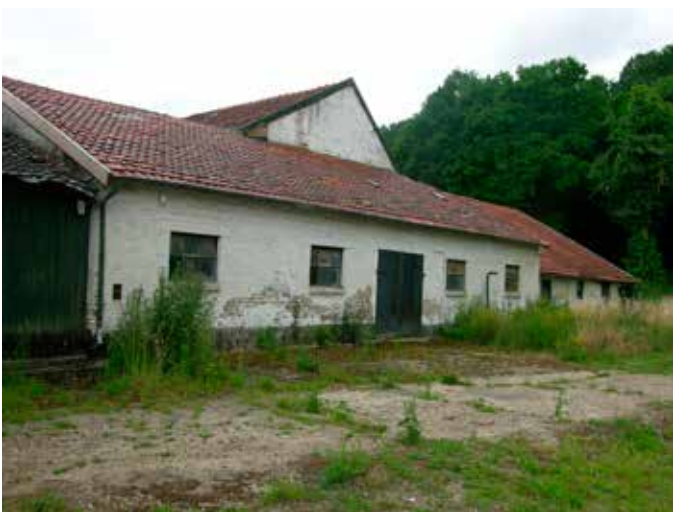
13. De stal ligt met de nok van het dak in het verlengde van de zijmuur van de schuur
