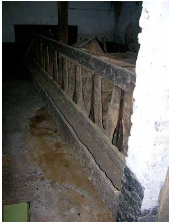
44. Detail van de voergang in de stal
