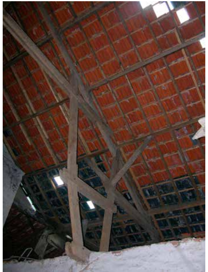
30. Het verbrande dak is na 1933 helemaal vervangen
