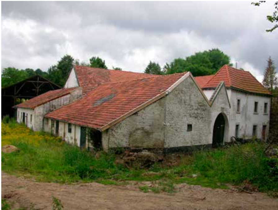
1. Overzicht over het complex zonder de vrijstaande annexen
