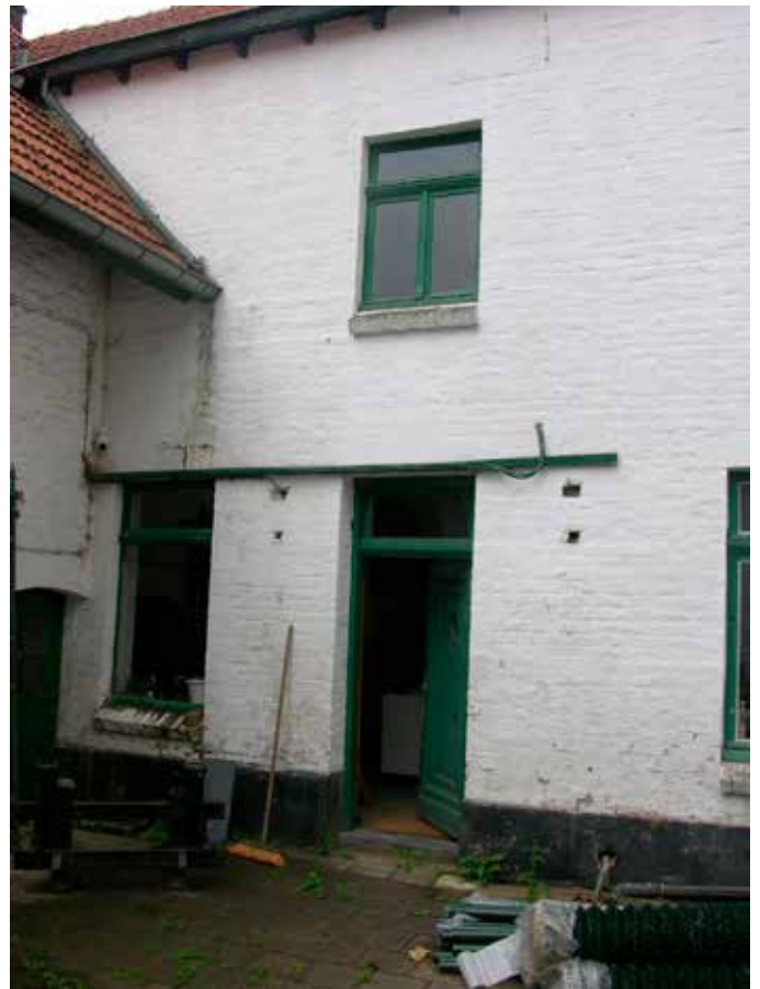
32. De zijmuur van de herbouwde woonhuisvleugel van na de brand met de deur naar het halletje
