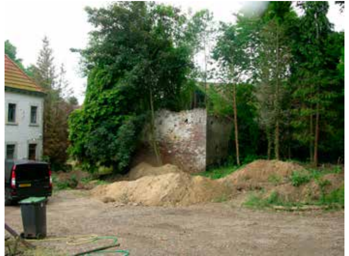
18. Schuin voor het woonhuis staat een belangrijk restant van een gebouw dat aanvankelijk verbonden was met de boerderij ernaast, in de tijd dat beiden een geheel vormden. Het gebouw had naar links, haaks op de nu bestaande massa, een verbinding met het woonhuis
