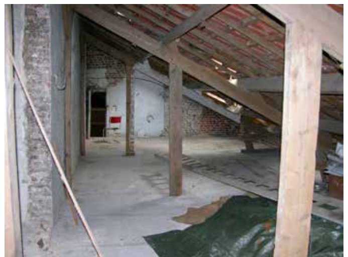
40. Het dak boven de zijdelingse aanbouw van de stalvleugel
