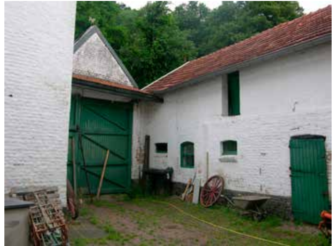
26. Het stuk achter de poort had voor de brand een dak dat doorliep tot de penant in het muurwerk van de stal. Daarvan is alleen het onderste deel oorspronkelijk, de rest is van na de brand
