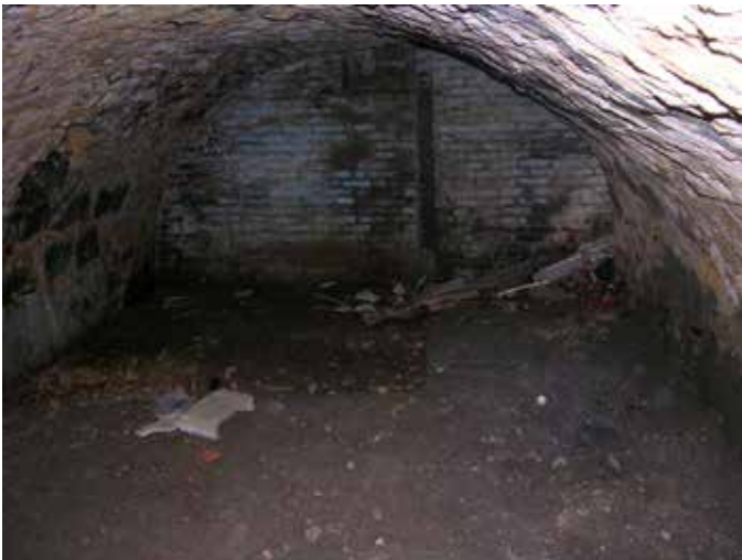
23. De kelder onder het linker deel loopt niet parallel aan de kopse gevel, maar er dwars op. Het onderste stuk van de gewelfmuren bestaat uit ouder metselwerk
