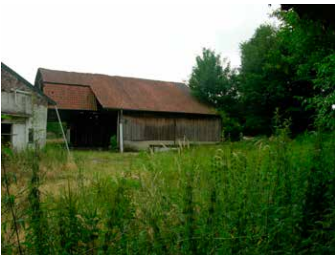
9. Vrijwel aansluitend staat daar weer achter het grotendeels open afdak op ijzeren spanten. Ook daar is het een en ander aangebouwd en uitgebreid
