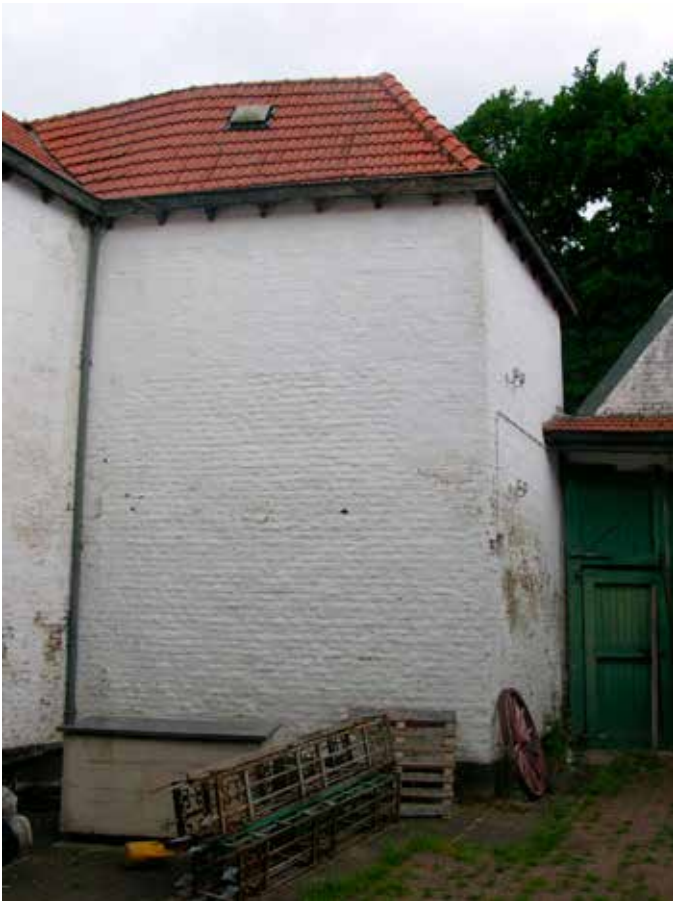
27. De achtergevel van het deel meteen rechts naast de poort, van buitenaf gezien, met duidelijke sporen van de herbouw na de brand. Aanvankelijk liep deze vleugel naar achter door als onderdeel van het oorspronkelijke woonhuis
