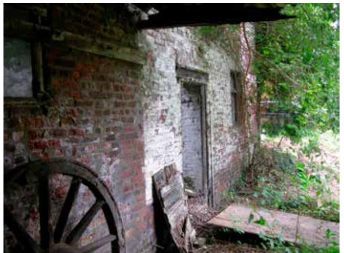
20. De gevel aan de woonhuiskant
