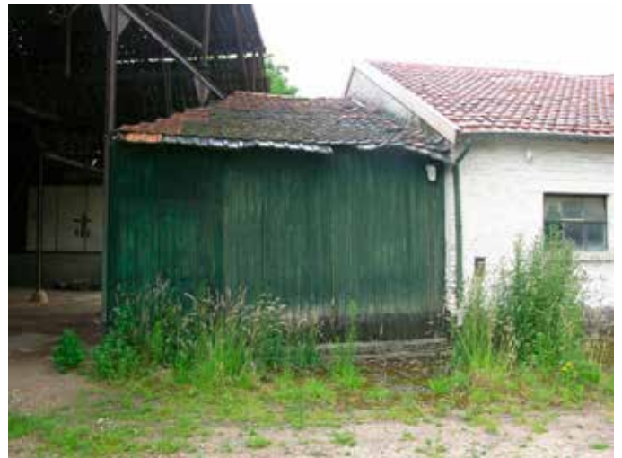
12. De verbinding van stal en stalling bestaat uit een vrij jonge constructie die beplankt is
