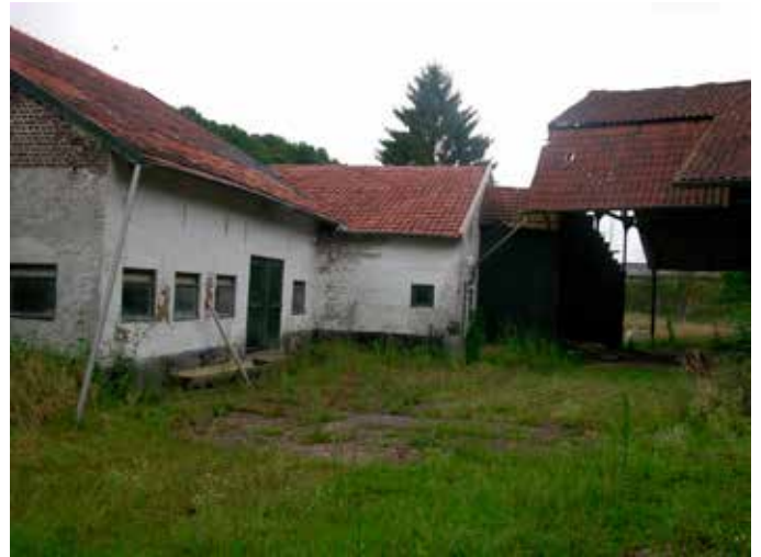
8. Tegen de schuur staat een latere uitbouw met een zadeldak haaks op het grote dak. Met de uitbreiding van de schuur samen vormt die een stal die om de hoek weer richting straat voert, en daar nog een keer aansluit op verdere stallen
