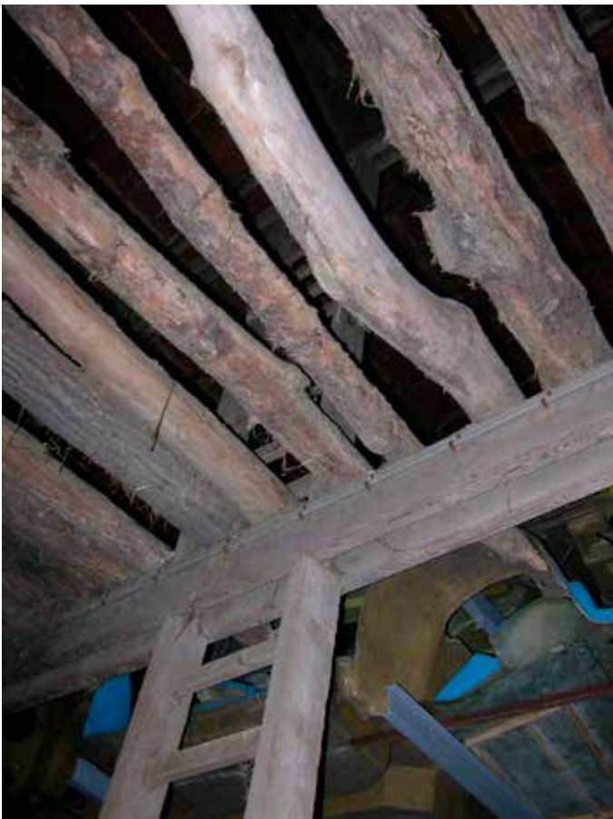
31. De spantconstructie is klassiek opgebouwd, compleet met hooiladder en 'bermhouten'
