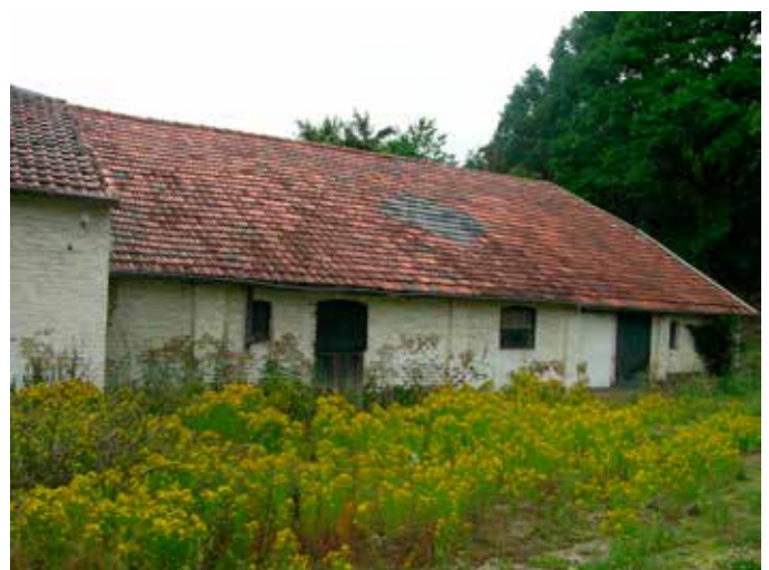
14. Aansluitend ligt een 19 de eeuwse stalgedeelte waarvan de muren bestaan uit penanten en relatief dunne tussenliggende wanden
