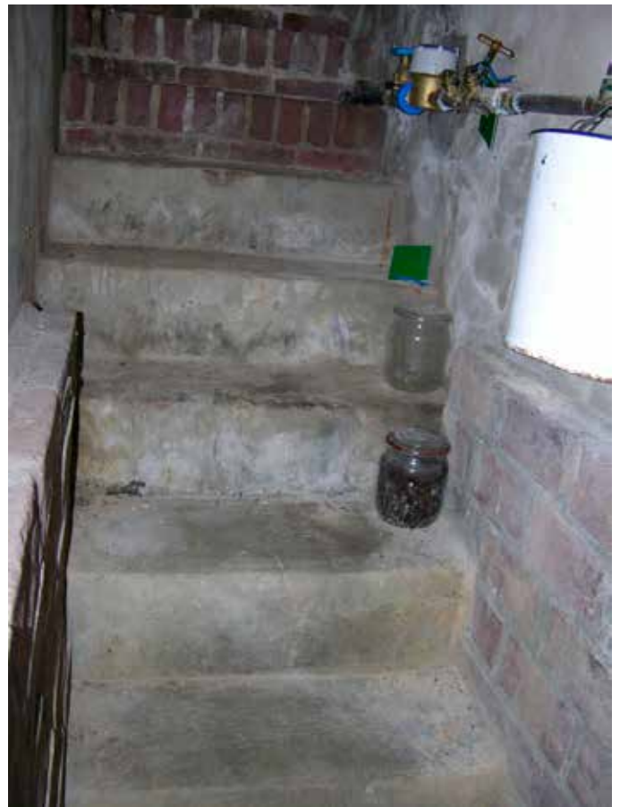
36. De kelder en de gecementeerde trap is ok toen aangelegd.....
