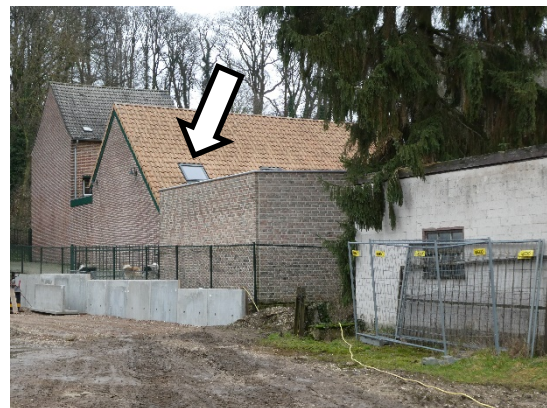
Figuur 12 Idem, foto genomen vanuit het oostelijk deel van het erf van hoeve Vulenbach
