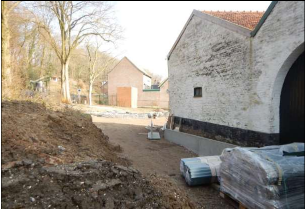
Figuur 18: Oostelijke deel van de noordelijke voorgevel met toegangspoort van de hoeve Vulenbach
