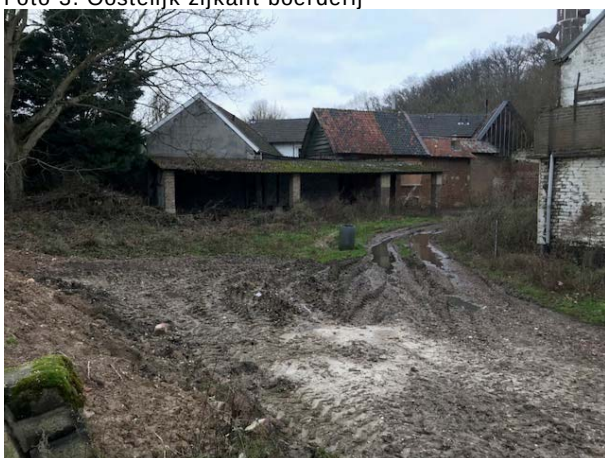
Foto 5. Overkapping voormalige dieseltank
