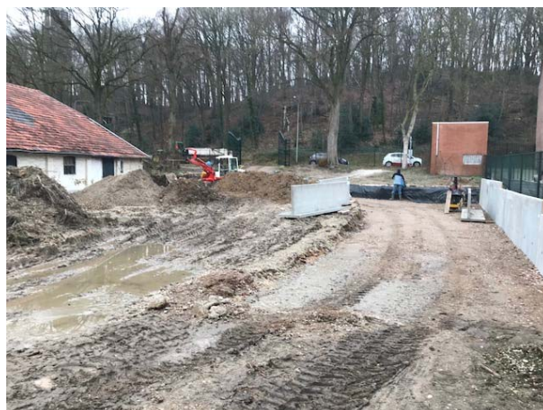
Foto 2. Zijkant ten oosten boerderij
