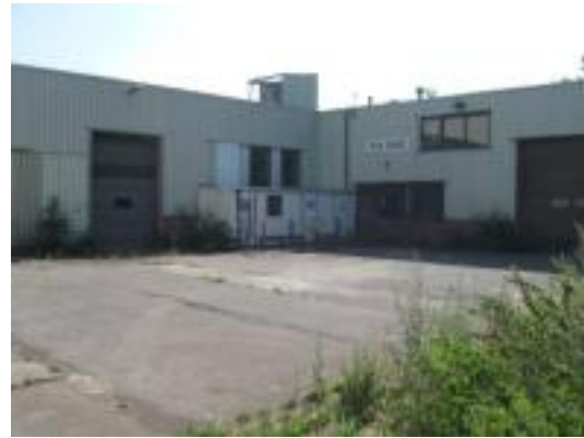
Figuur 4: Deelgebied 1: achterzijde bedrijfsgebouw, in oostelijke richting gezien.
