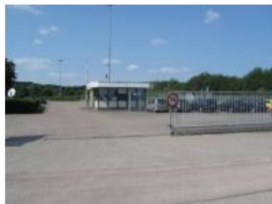
Figuur 8: Kavel 3: parkeerterrein met portiergebouw, vanaf de Vogelzankweg in zuidwestelijke richting gezien.
