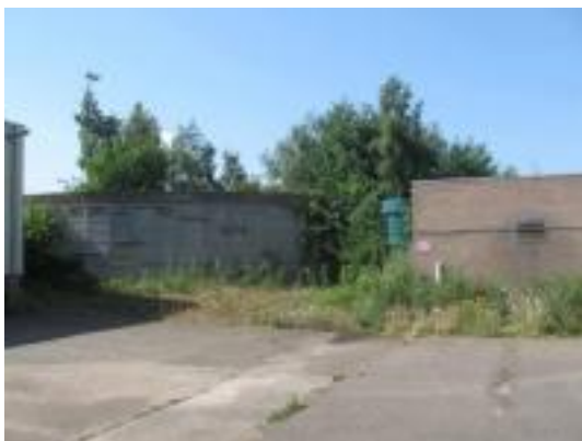
Figuur 5: Kavel 1: waterbassin en bijgebouw, vanaf het bedrijfsgebouw in zuidwestelijke richting gezien.
