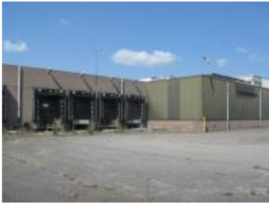
Figuur 3: Kavel 1: voorzijde bedrijfsgebouw, vanaf de Vogelzankweg in zuidwestelijke richting gezien.
