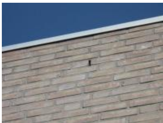
Figuur 11: Deelgebied 1: één van de ventilatieopeningen in de zuidgevel die geschikt lijken voor vleermuizen.
