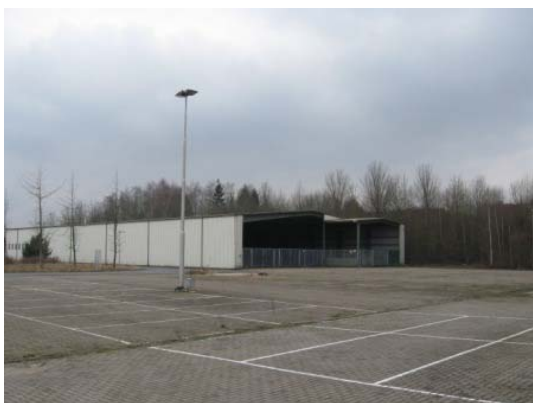
Figuur 5: De plaatstalen voormalige buizenopslag en parkeerterrein, gezien in zuidwestelijke richting.
