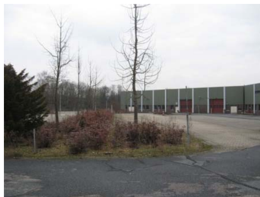
Figuur 6: Parkeerterrein en groenvoorziening aan de westzijde van het grote bedrijfsgebouw (op achtergrond), gezien in oostelijke richting.
