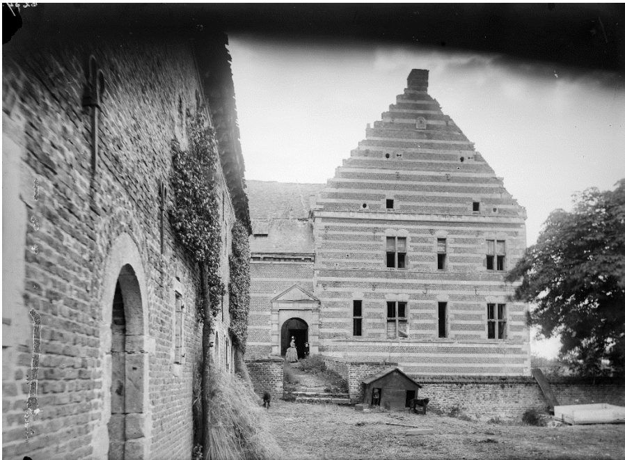
Het kasteel in 1888, gezien vanuit het westen, met een nog intacte brug. De vorm met een drietred en een oplopend deel naar de poort is hier goed te herkennen. Op deze foto wordt het binnenplein van de voorburcht nog door een lage bakstenen muur afgesloten aan de zijde van het kasteel. Omstreeks 1900 zal hier een lage bedrijfsvleugel verrijzen, die het kasteel visueel afsloot ten opzichte van de voorburcht. (Foto: RCE)
