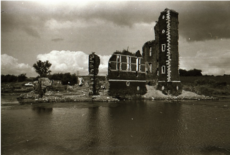
Overzicht van de ruïne, gezien vanuit het zuiden ten tijde van het vrijgraven. Van het smalle en hoge fragment aan de linker zijde van het nog bewaarde deel van de zuidgevel is het bovenste deel thans niet meer aanwezig. (Foto: Hukkelhoven, Documentatie Heemkundevereniging)
