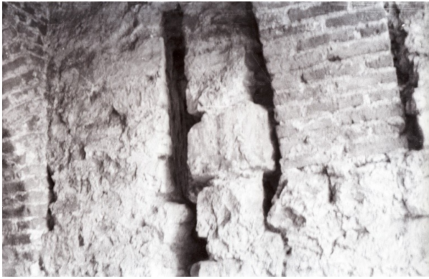
Het schietgat, maar nu gezien vanaf de andere zijde. Het bakstenen metselwerk rechts van het schietgat zal de aanzet zijn van een van de gordelbogen. (: 1952, Collectie Corten)
