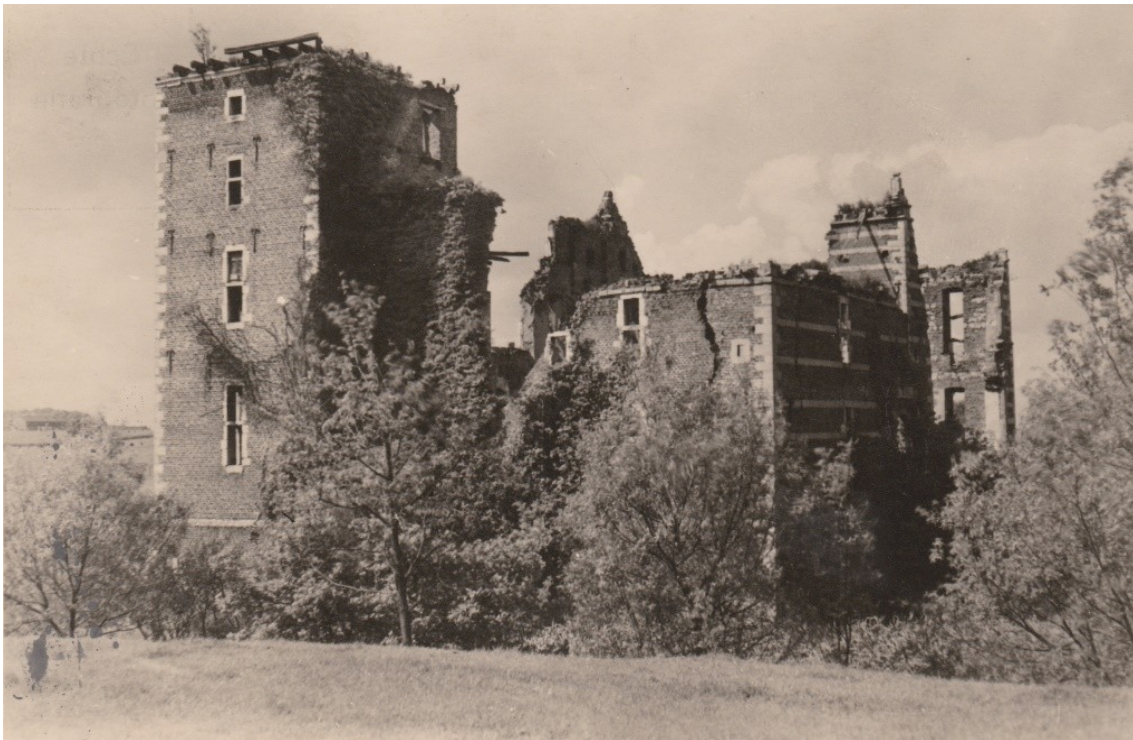
Omstreeks 1938 staat het grootste deel van de buitengevels nog overeind. Wel is de noordgevel van de westvleugel ingestort. (Prentbriefkaart: Collectie Corten)
