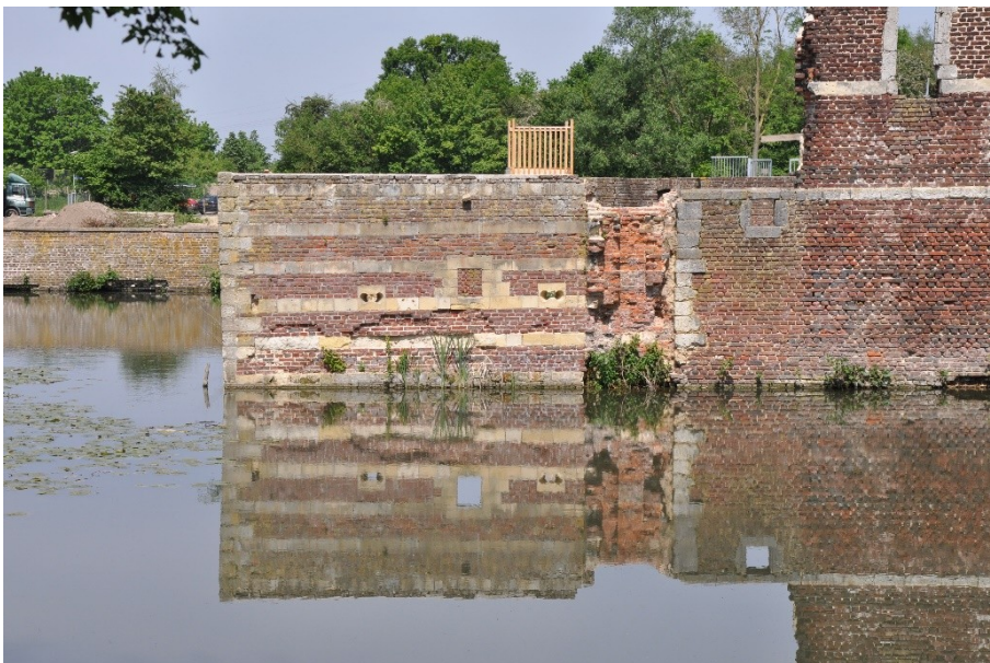
Zicht op het meest westelijke deel van de zuidgevel. In 1975 was dit deel tot op het niveau van de gracht verdwenen. Al het hier zichtbare metselwerk is bij de consolidatie van 1975 en daarna tot stand gekomen. Het toen opgetrokken metselwerk bestaat uit een kern van betonblokken met aan weerszijden ervan een halfsteens zware beklamping van veldbrandstenen met spekbanden van mergel. Door vermoedelijk vocht en vorstinwerking op dit metselwerk zijn schollen afgesprongen. De spekbanden van mergel zijn plaatselijk volledig verdwenen, waardoor de mortel en betonblokken van de kern zichtbaar zijn geworden. Ook bij de noordgevel is dit schadebeeld aanwezig.
