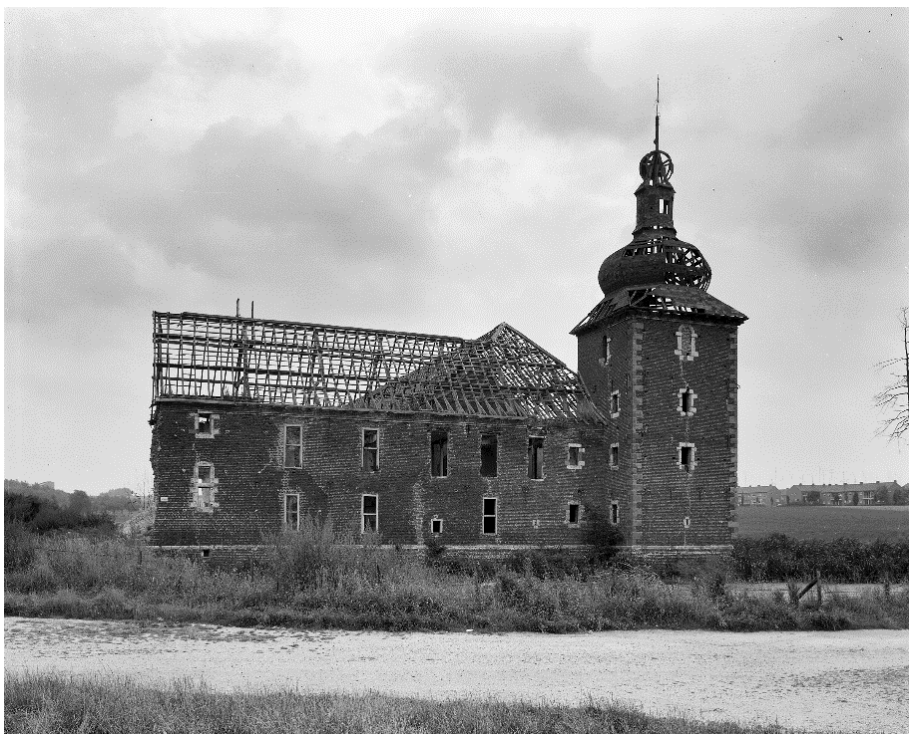
Het westelijke deel van de bouwhoeve was reeds voor het verstrekken van de sloopvergunning van zijn dakbedekking ontdaan. (Foto: RCE)
