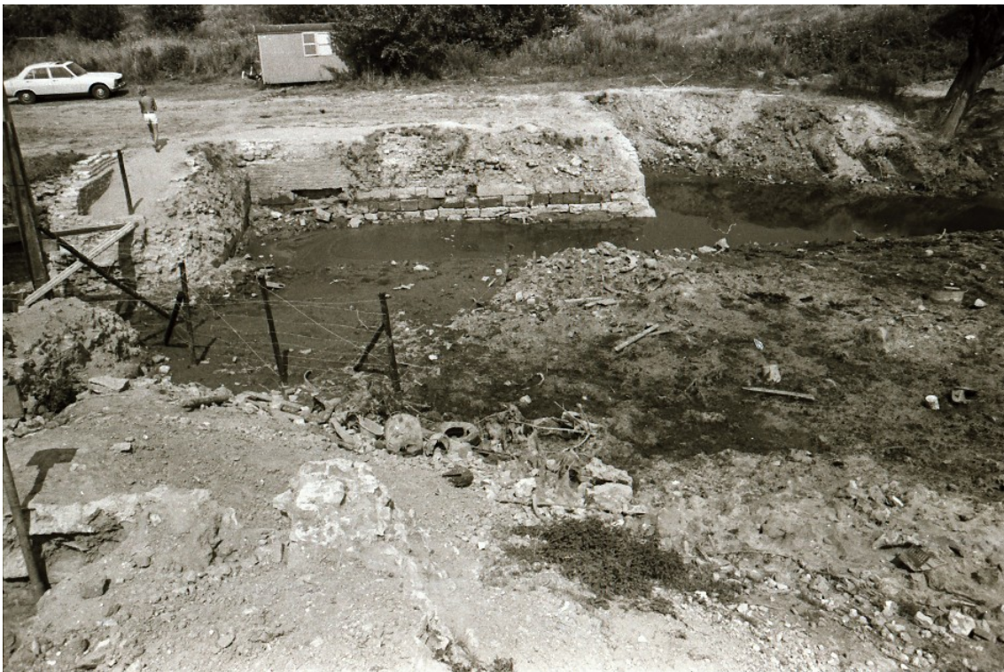
Het meest oostelijke deel van de zuidgevel van de bouwhoeve in 1975. Bij het begin van de consolidatie was van dit deel alleen de natuurstenen onderbouw bewaard gebleven, alsmede een deel van het metselwerk direct ten oosten van de brug. (Foto: Hukkelhoven, Documentatie Heemkundevereniging)
