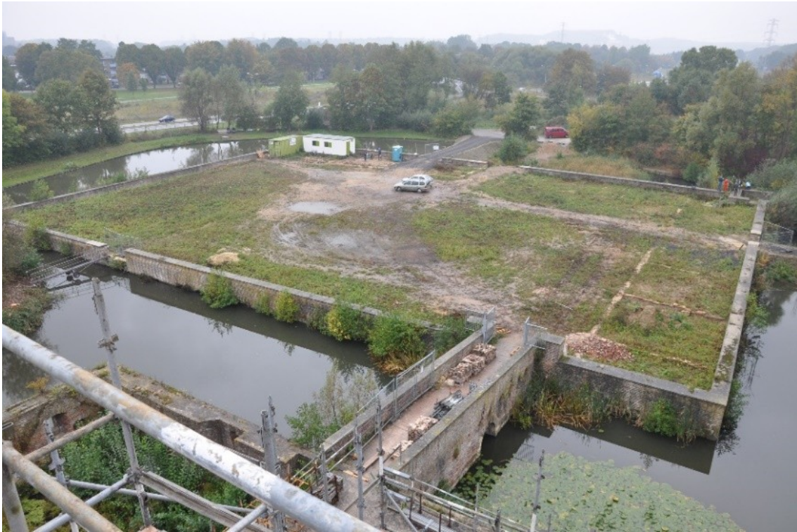
Overzicht van het in de zeventiger jaren van de vorige eeuw geconsolideerde metselwerk van de voorburcht. De foto is in noordwestelijke richting genomen.
