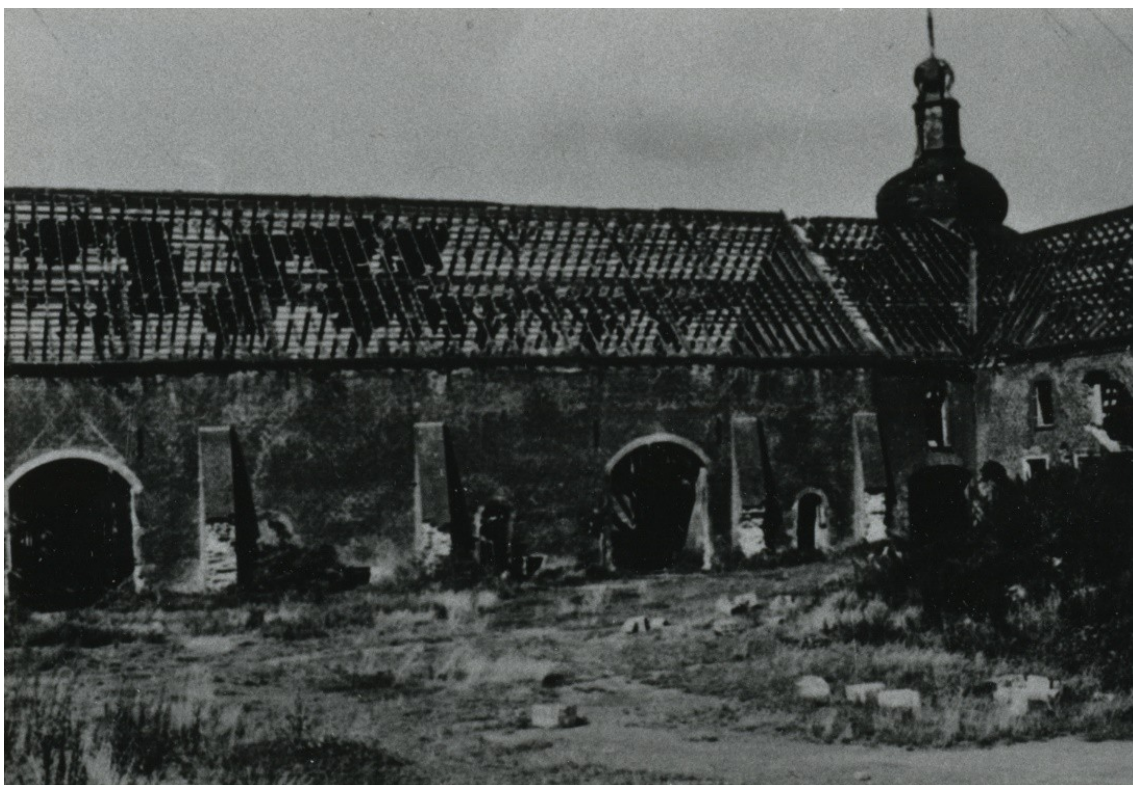
Reeds voor het verstrekken van de sloopvergunning is een aanzienlijk deel van de bouwhoeve gededemonteerd. (Foto: Rijckheyt, Heerlen)
