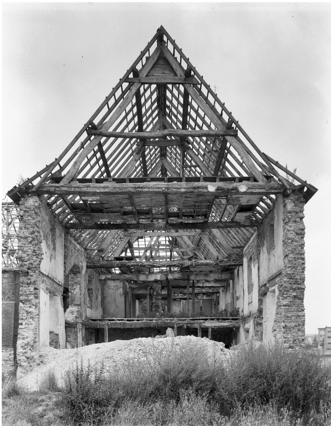
De woonvleugel in augustus 1967, dus nog voor de sloopvergunning was afgegeven. Men kan zich niet aan de indruk onttrekken, dat toen reeds (illegale) sloopwerkzaamheden waren uitgevoerd. In wiens opdracht deze zijn uitgevoerd, is in de archieven niet meer te achterhalen. (Foto: RCE)
