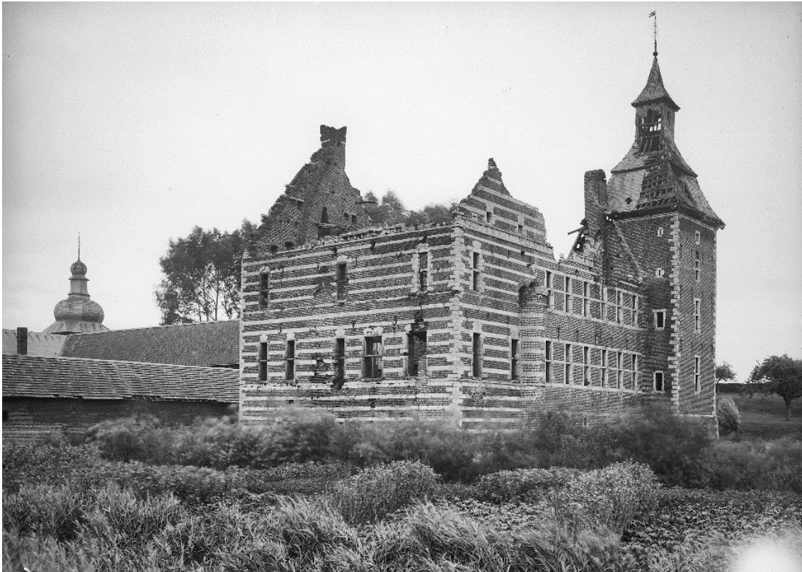
Het kasteel in 1919. Vrijwel al het metselwerk is op dat moment nog aanwezig. De toren is nog voorzien van zijn kap, hoewel deze al in een slechte staat van onderhoud verkeerde. (Foto: RCE)
