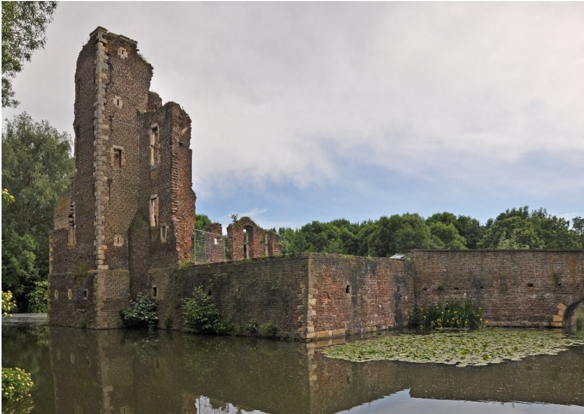
Het kasteel onder dezelfde hoek gefotografeerd, maar dan dichterbij in het voorjaar van 2014. Met uitzondering van het torenfragment met het aansluitende deel van de oostgevel is al het metselwerk bij de consolidatie van 1975 tot stand gekomen.
