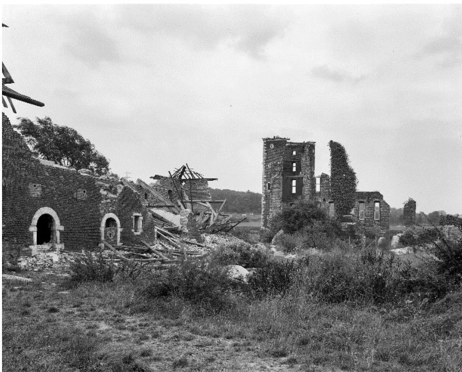
De oostvleugel van de bouwhoeve in de periode van voor de sloopvergunning. (Foto: Rijkheyt, Heerlen)
