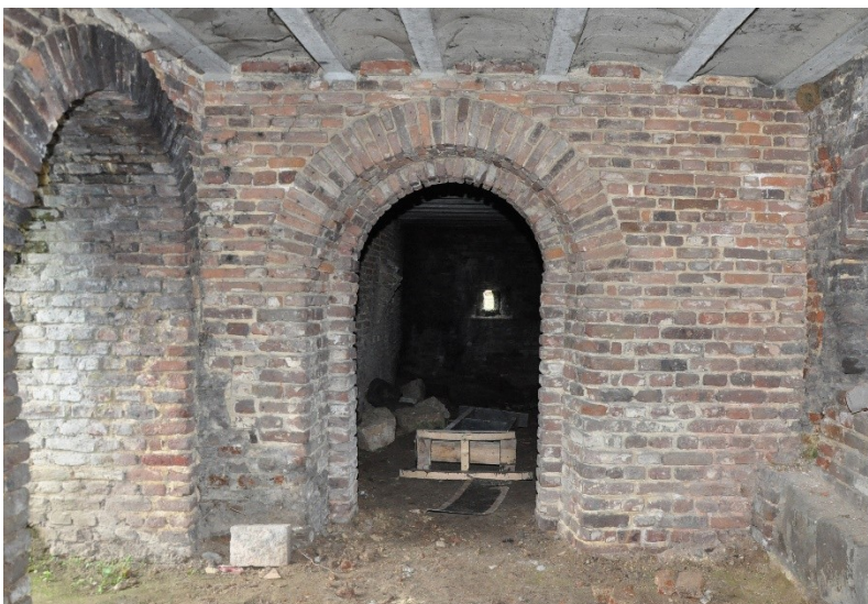
Zicht op de noordwand van de ruimte tussen de ruimte op de noordoosthoek en de toren. Het oorspronkelijke metselwerk bevindt zich bij (A). Het metselwerk bij (B) is herstelwerk uit 1975 en daarna.
