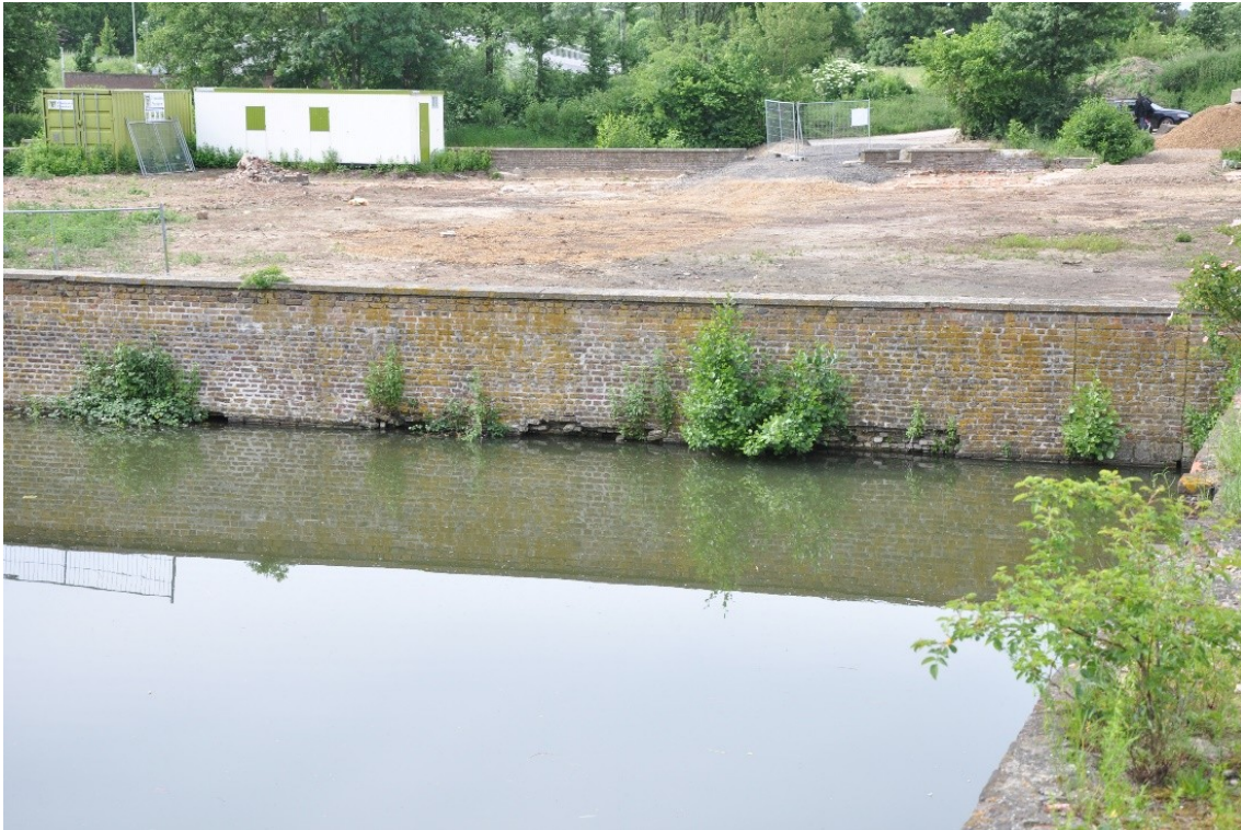
Overzicht van de zuidgevel ten westen van de brug naar het kasteel in 2014. Geheel rechts op de foto zijn twee verticale naden in het metselwerk opgenomen. Aan te nemen is dat men bij de consolidatie hiermee een bouwspoor heeft willen aangeven. Documentatie of andere informatie over beide naden is niet aangetroffen, waardoor we in het duister tasten ten aanzien van de interpretatie van dit spoor.
