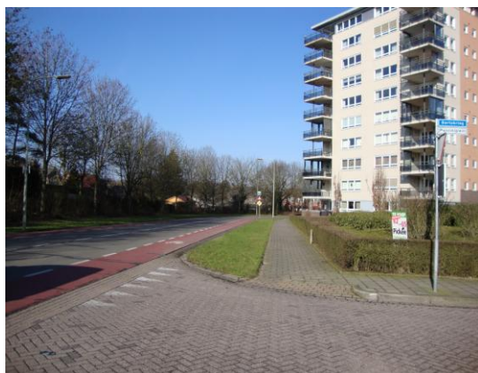
Appartementencomplex overzijde Bartokring
