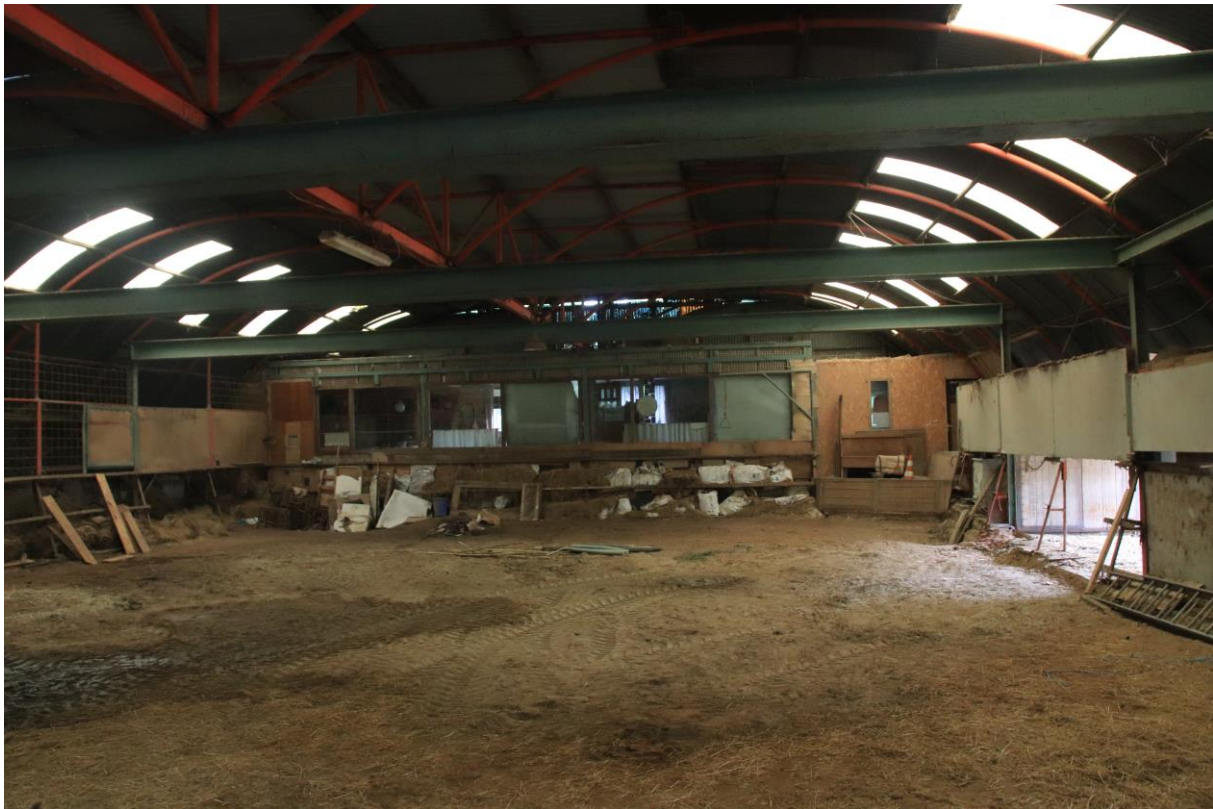
De te slopen voormalige paardenrijbak
