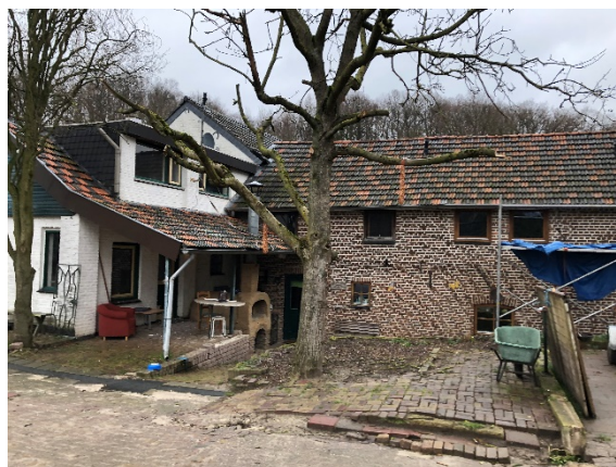
Figuur 6 Zuidwest- en zuidoostgevel Hoverveldweg 5
