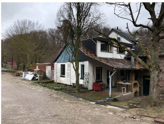
Figuur 7 Zuidwest- en zuidoostgevel Hoverveldweg 5
