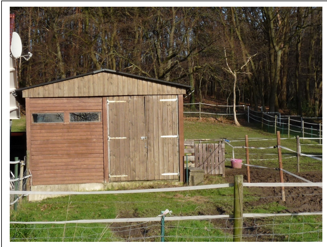
Foto 3. Te verwijderen houten paardenstal
