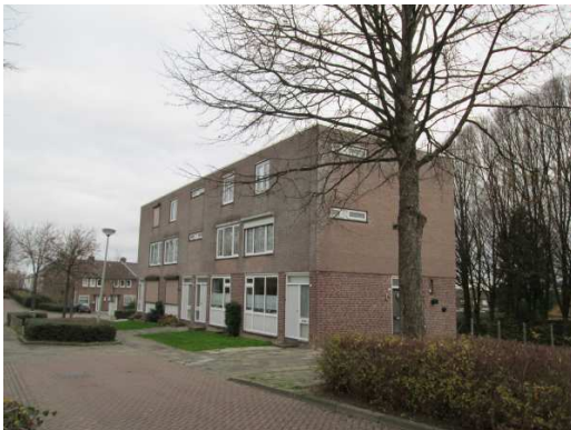
Woningen op bouwlocatie Irenestraat
