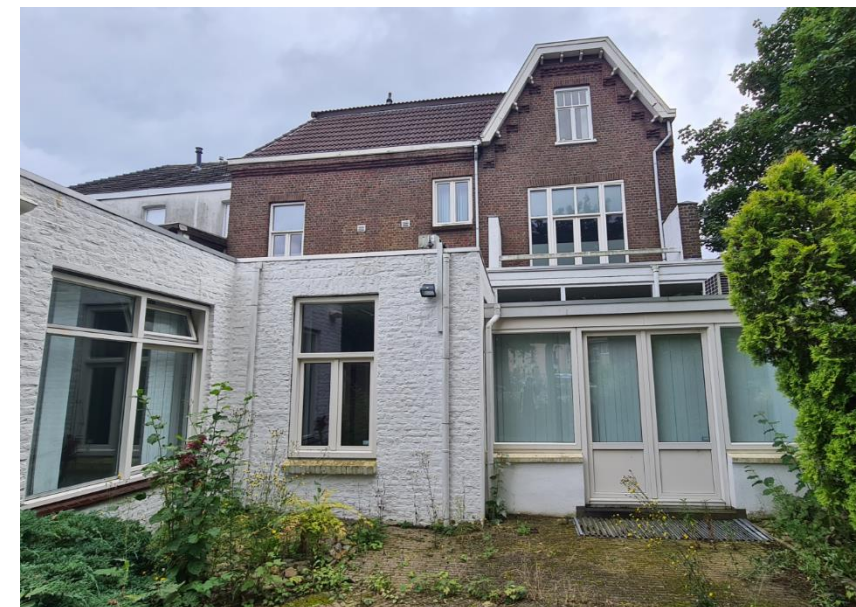
Figuur 5: Kantoorgebouw gezien vanuit het noorden
