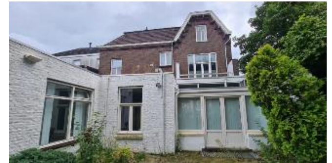
Figuur 6: Kantoorgebouw gezien vanaf het noorden
