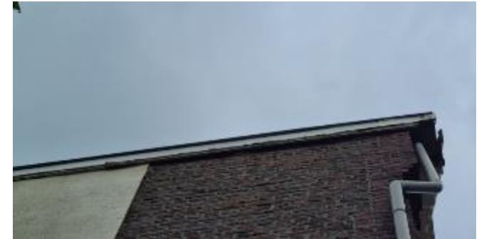
Figuur 5: Westelijke dakrand van kantoorgebouw
