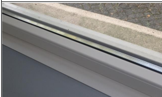
Foto 37 kunststof kozijnen muur zolderverdieping
