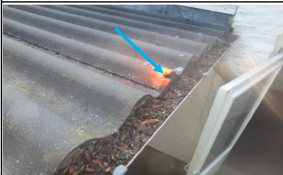
Foto 21 niet asbesthoudende golfplaten afdak tuin
