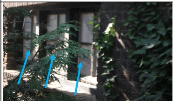
Foto 26 niet asbesthoudende stopverf kozijnen garage
