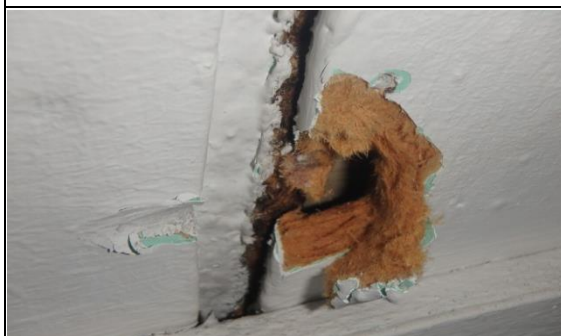
Foto 33 zachtboard plafondbetimmering zolder
