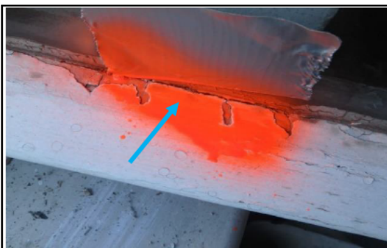
Foto 15 niet asbesthoudende stopverf kozijn zolderkamerss
