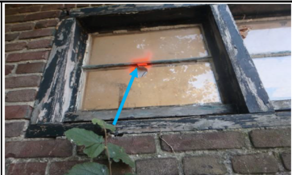
Foto 24 niet asbesthoudende stopverf kozijnen garage
