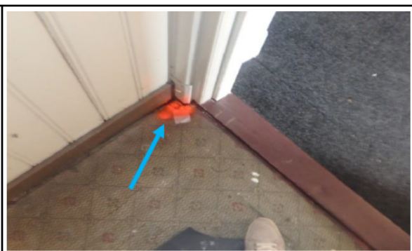
Foto 13 niet asbesthoudend vloerzeil gang zolder
