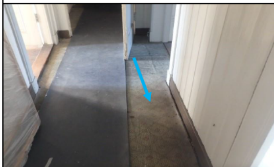
Foto 14 niet asbesthoudend vloerzeil gang zolder
