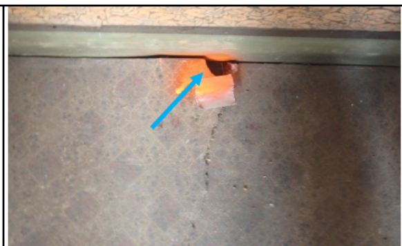
Foto 10 niet asbesthoudend vloerzeil kast zolderkamer
