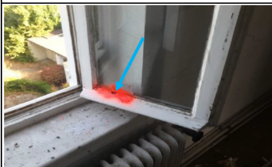
Foto 17 niet asbesthoudende stopverf kozijn zolderkamers
