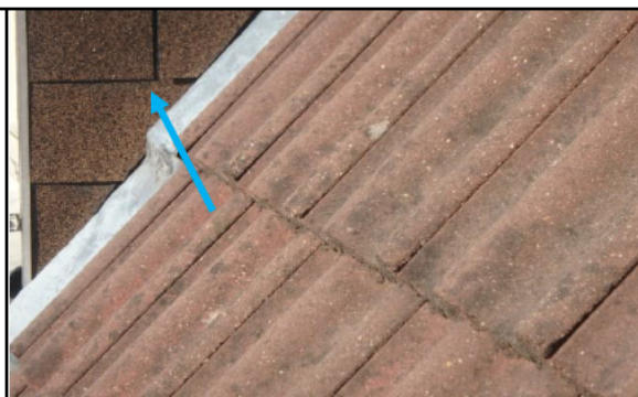
Foto 6 niet asbesthoudende singles dakkapellen
