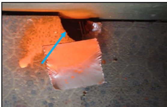
Foto 9 niet asbesthoudend vloerzeil kast zolderkamer
