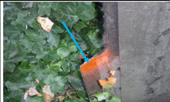
Foto 28 niet asbesthoudend dakleer garage
