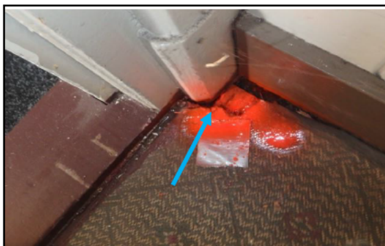
Foto 12 niet asbesthoudend vloerzeil gang zolder
