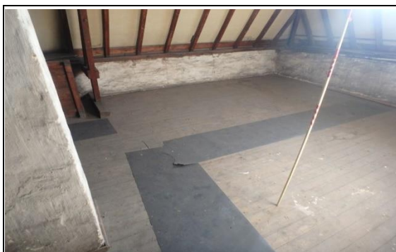
Foto 31 planken vloeren zolderverdieping
