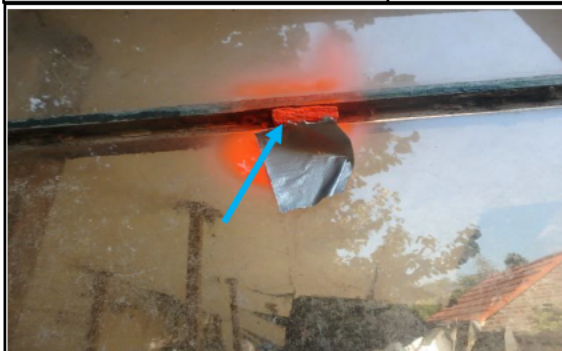
Foto 23 niet asbesthoudende stopverf kozijnen garage
