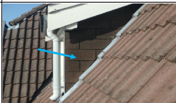
Foto 8 niet asbesthoudende singles dakkapellen
