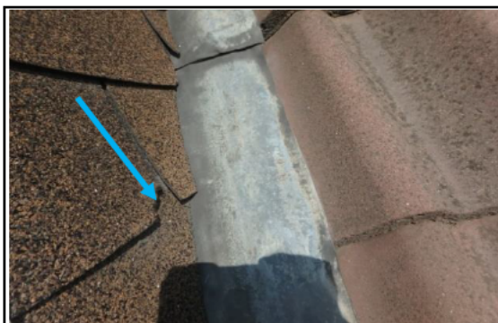
Foto 5 niet asbesthoudende singles dakkapellen
