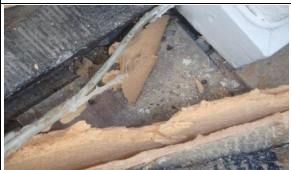
Foto 34 houten plaat onder vloerbedekking
