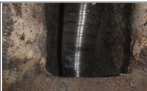
Foto 32 gemetseld kanaal met flexibele buis
