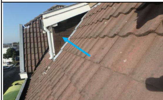
Foto 7 niet asbesthoudende singles dakkapellen
