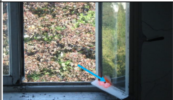
Foto 18 niet asbesthoudende stopverf kozijn zolderkamers
