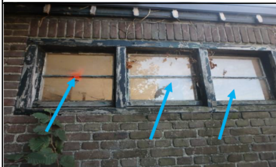
Foto 25 niet asbesthoudende stopverf kozijnen garage
