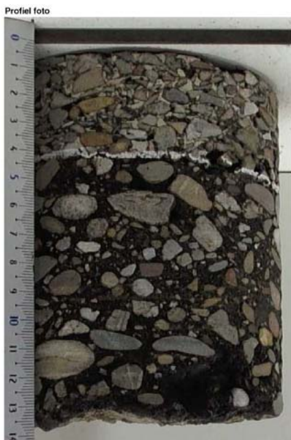
Figuur 4: Asfaltkern A1
