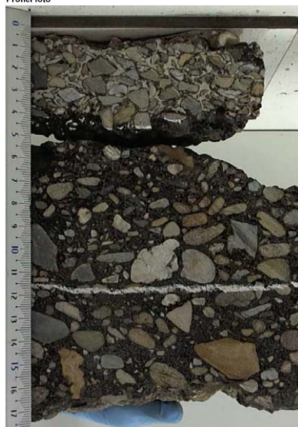
Figuur 5: Asfaltkern A2
