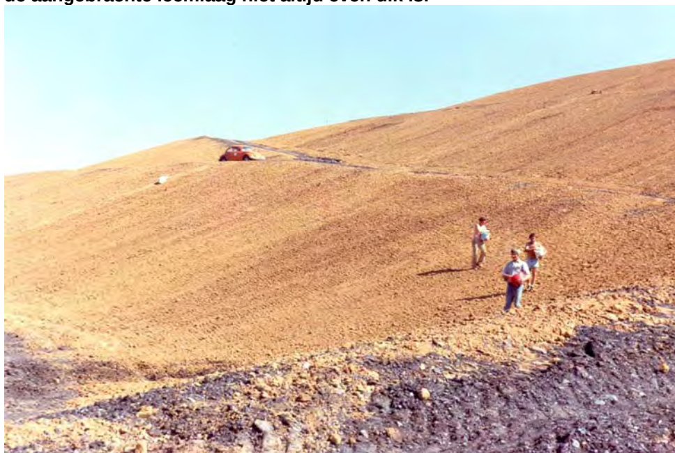
Foto 6: de mijnsteenbergen van de Wilhelmina wordt ingezaaid met gras. Duidelijk zichtbaar is dat de aangebrachte leemlaag niet altijd even dik is.
