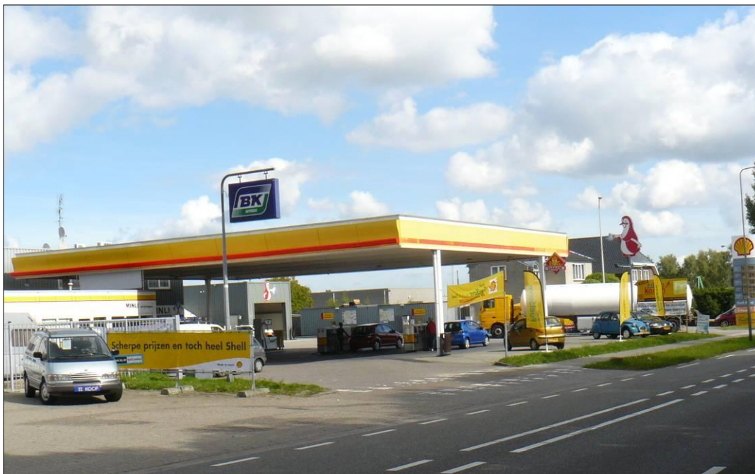
tankstation met LPG, gelegen aan de Einsteinstraat
