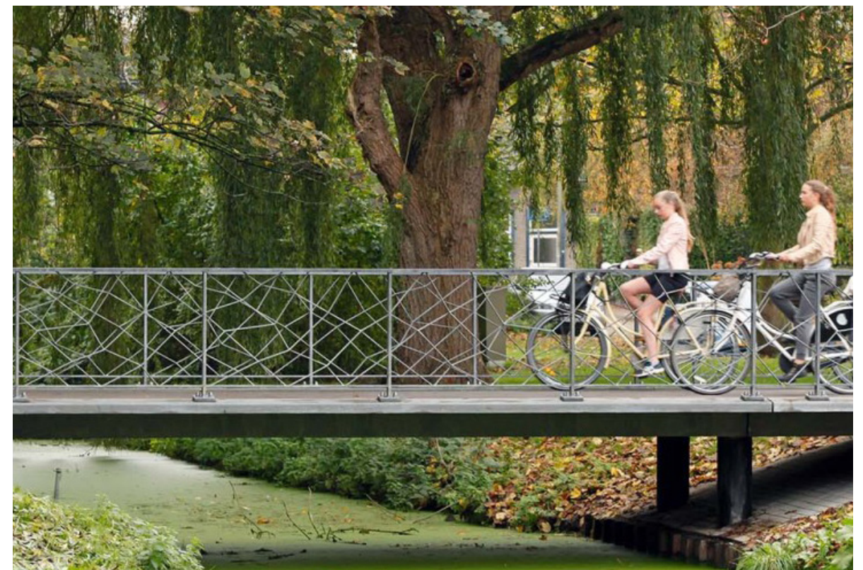
Referenties (railing en hoge sterkte beton brug)
