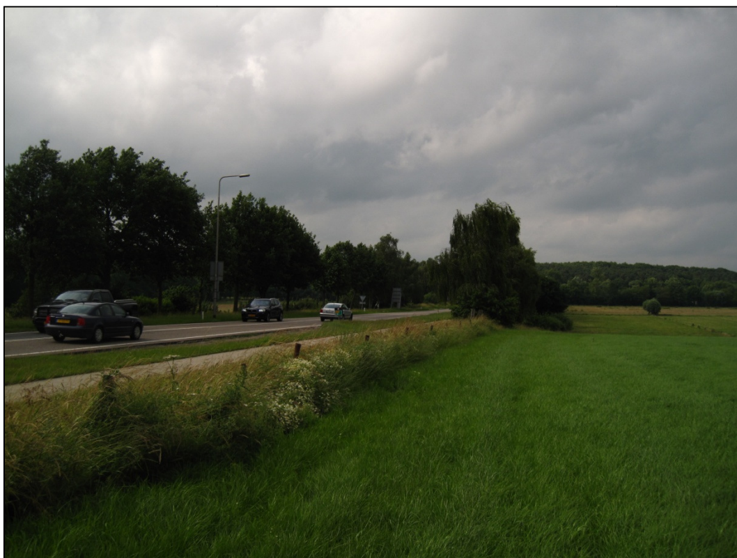
Afb. 4 In het dal van de Roodebeek is de provinciale weg op een kunstmatige verhoging aangelegd.
