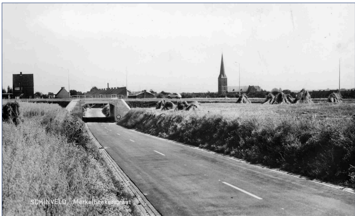
Figuur 21: Het viaduct van de N274 over de Merkelbeekerstraat. 47
