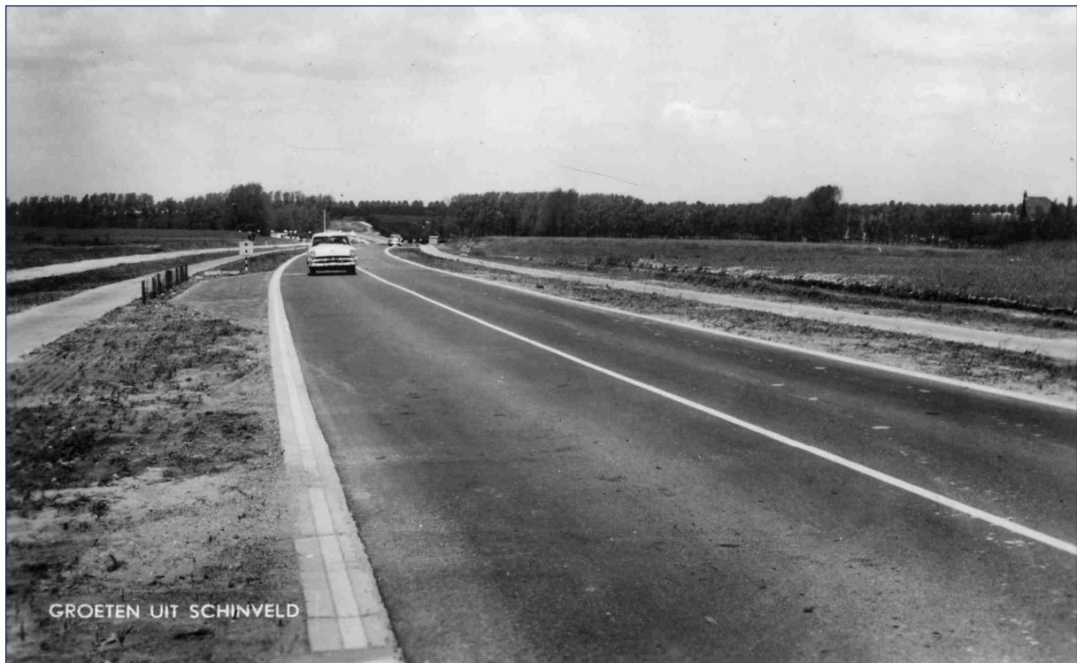
Figuur 20: De N274 in noordelijke richting net na het viaduct over de Merkelbeekerstraat. 46
