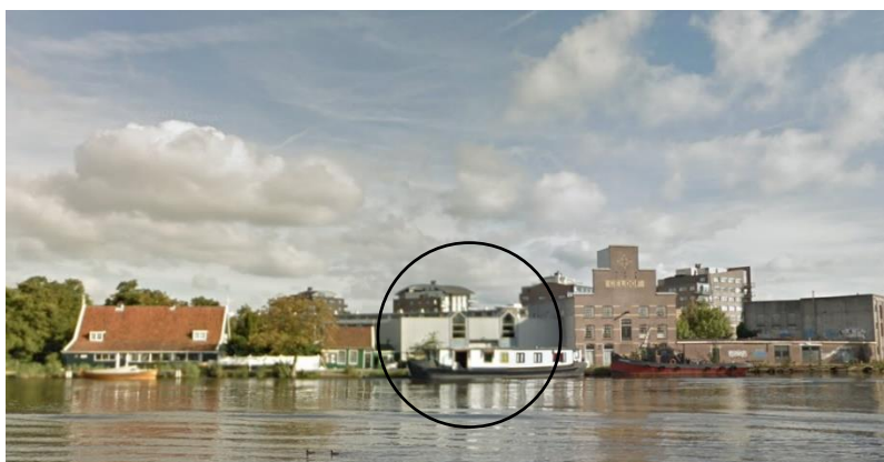
Zicht vanaf Wormerveer op Veerdijk 60 (omcirkeld): Anoniem bedrijfspand zonder karakteristieke waarden.
