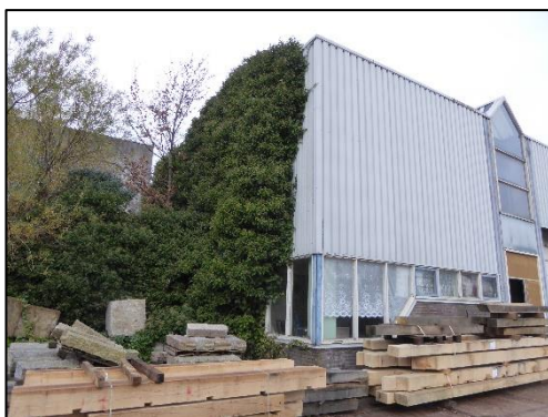
De achterzijde van het bedrijfspand met de klimophaag;
