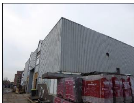
De noordkant van de achterzijde.
