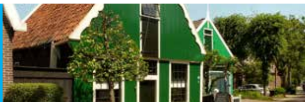
houten gevels in het straatbeeld van Jisp
