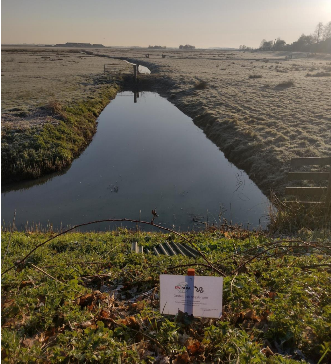
Figuur 6: Golfplaten aan de oostzijde van het plangebied.
