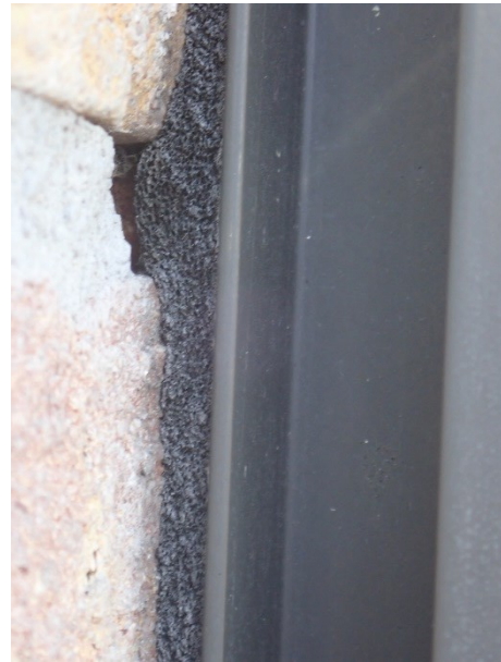
Foto 6: rechts, de afsluiting met compressieband tussen de kozijnen en de muur.
