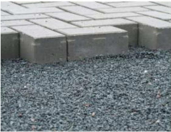
Figuur 14 Voorbeeld waterbergende wegfundering
