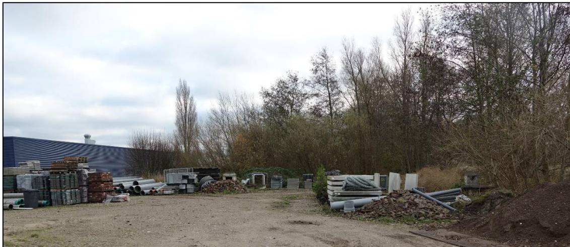
Figuur 8: Bouwterrein met opslag van bouwmaterialen binnen het plangebied (deelgebied 4 uit Figuur 2).
