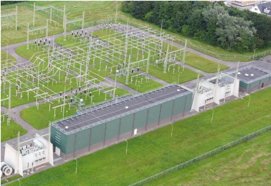
afbeelding 5: detailbeeld bestaande bebouwing (bron: HoogspanningsNet Netkaart)
