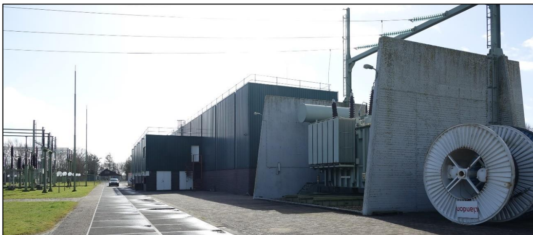
Figuur 2: Op het hoogspanningsstation staan enkele gebouwen, de onderste verdieping bestaat deels uit baksteen en gaat over in metalen constructies.
