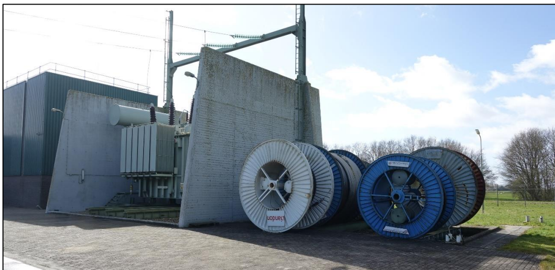
Figuur 6: Een tweede locatie betreft een verhard deel waar nu grote spoelen met kabels liggen.
