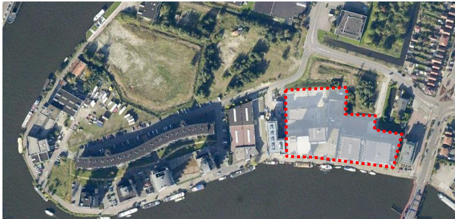
Ligging Veerdijk 39 t/m 43 (Bron: Google Earth)
