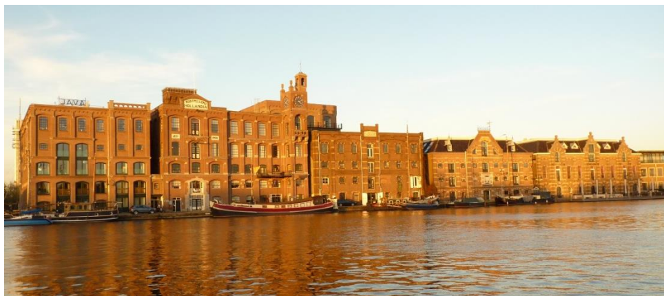
Huidige situatie Veerdijk 43 t/m 39
