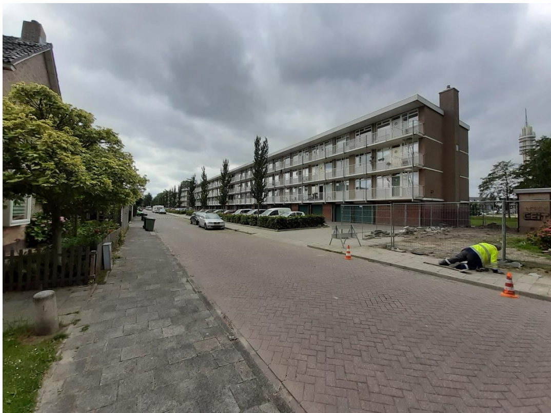
Flat met plat dak aan de Gele Lisstraat
