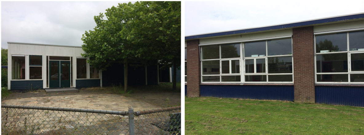
Afbeelding 7: het dak van de te slopen gebouwen hebben geen dakpannen
