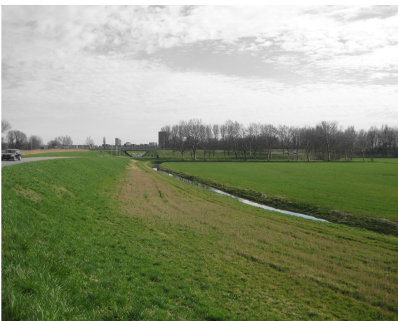
Zicht op de dijk
