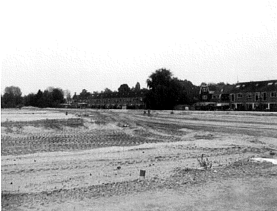
Foto 16. 26-10-07 centraal noordwest naar zuidoost leeflaag met bouwweg woningen Knollendammerstraat
