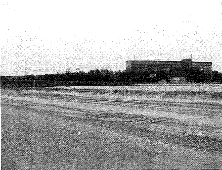
Foto 15. 26-10-07 centraal zuidwest naar noordoost leeflaag met bouwweg en niveau woning met tuin
