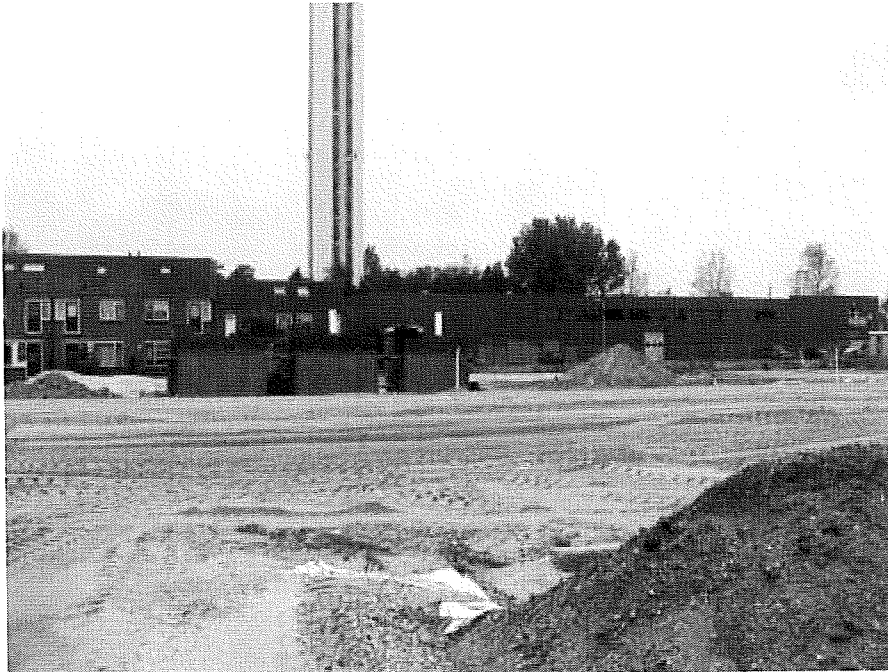
Foto 18. 26-10-07 centraal noord naar zuid leeflaag met bouwweg woningen Knollendammerstraat en zuiveringsunit 1 en hiernaast vlek 9
