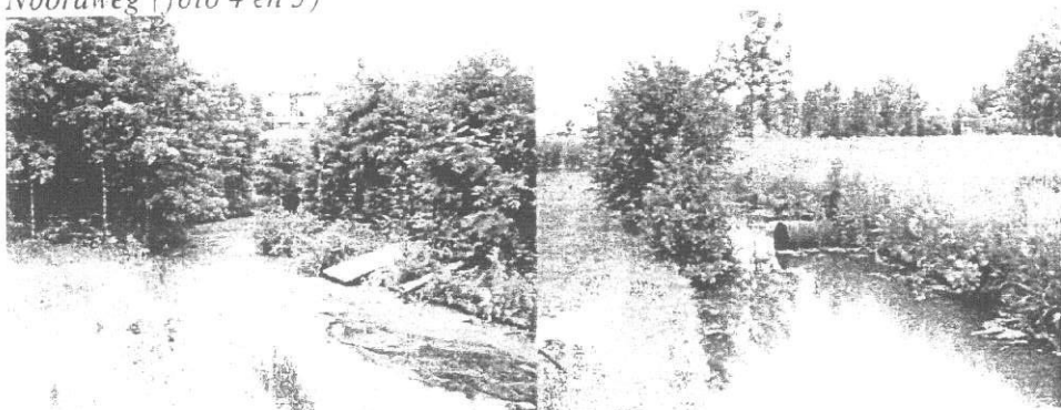
Sloot achter Knollendammerstraat en sloot langs Noordweg, met duiker onder Noordweg (foto 4 en 5)
