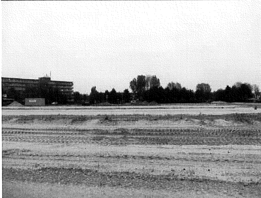
Foto 16. 26-10-07 centraal zuidwest naar noordoost leeflaag met bouwweg en niveau woning met tuin
