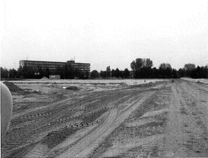
Foto 13. 26-10-07 centraal west naar oost leeflaag met bouwweg
