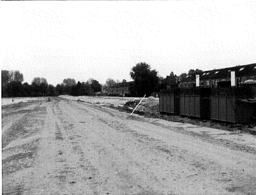
Foto 14. 26-10-07 centraal west naar oost leeflaag met bouwweg
