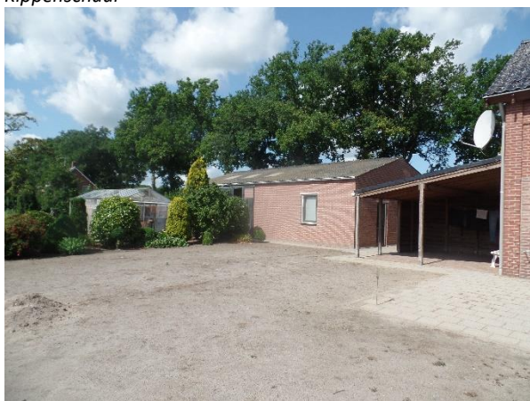
Kleine schuur waarvan het linkerdeel gesloopt wordt
