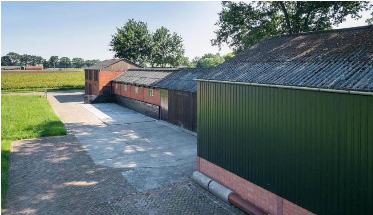
Figuur 11: Bedrijfsgebouw voorzien van goten en rondom verharding aanwezig
