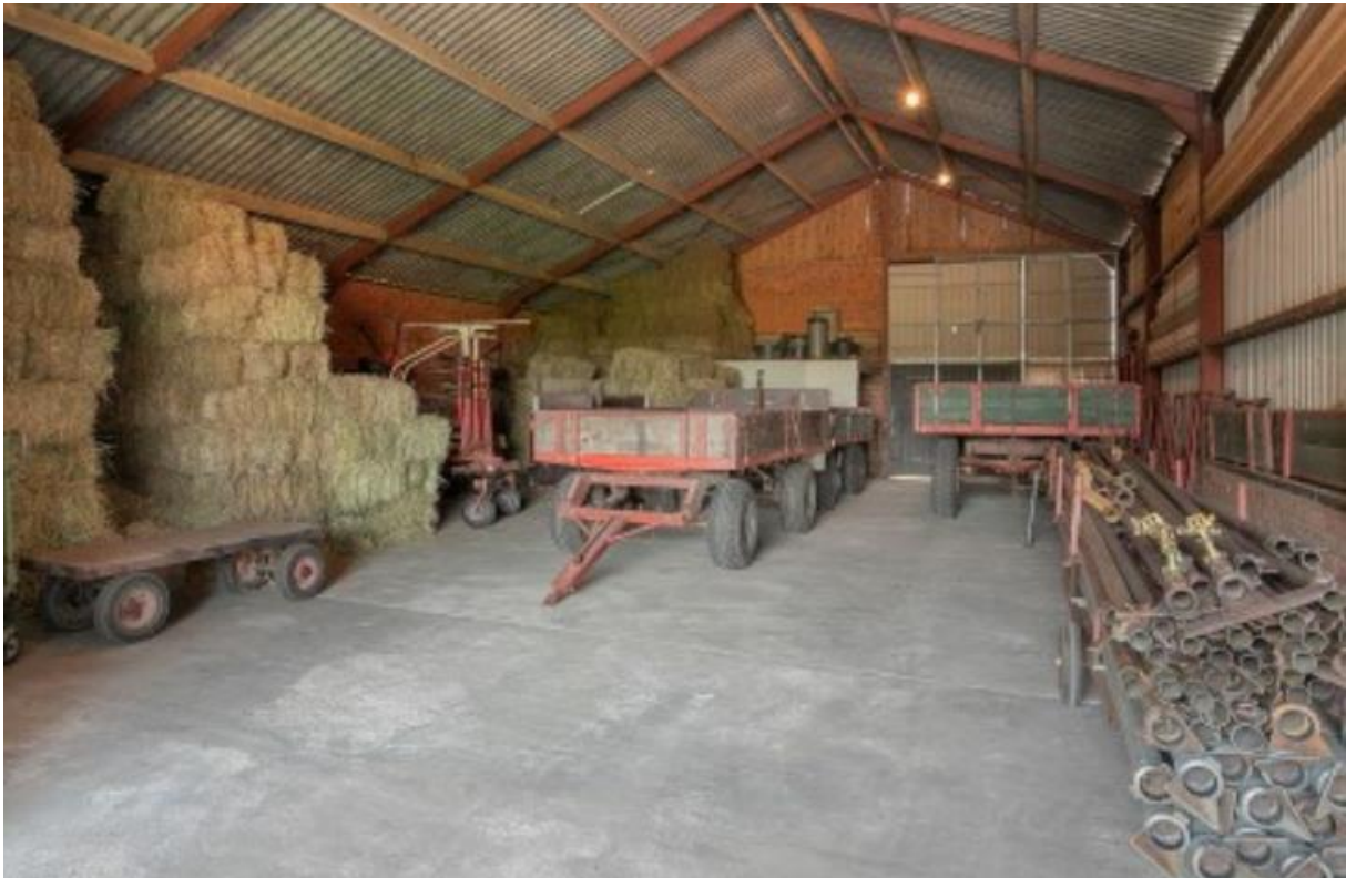
Figuur 12: Bedrijfsgebouw inpandig voorzien van betonvloer
