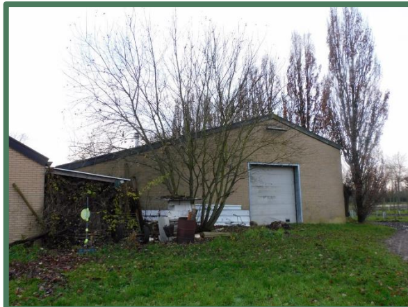
Noordzijde loods plangebied
