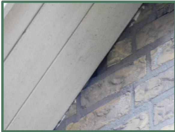
Ruimte tussen de wand en het dak
