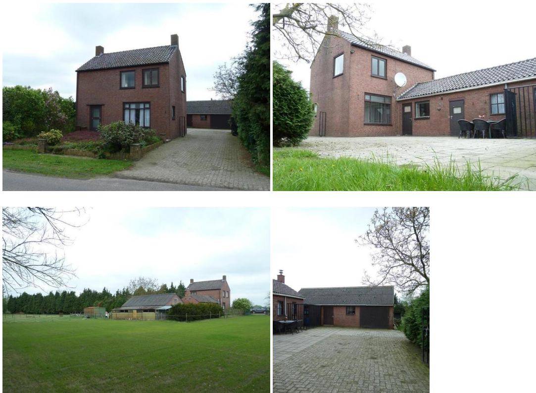
Figuur 4: Foto's bestaande situatie Overasebaan 6
