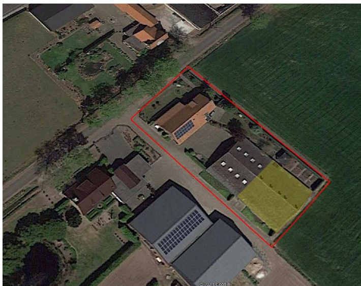
Fig.2. De bestaande situatie. Het gehele plangebied is rood omkaderd. De gele markering geeft aan welk deel van de bebouwing gesloopt wordt.
