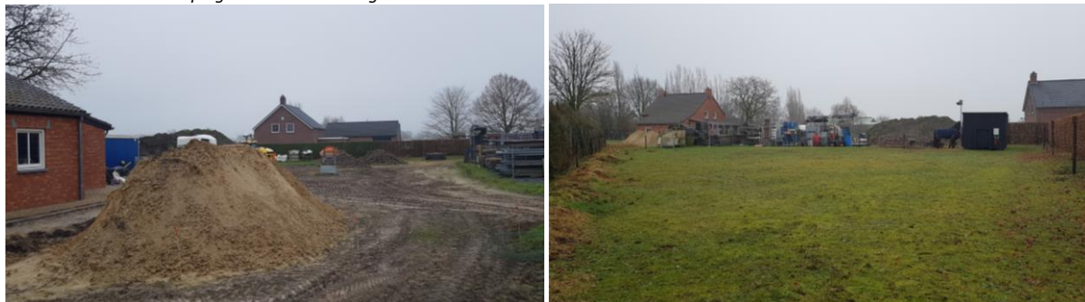
Foto's situatie na sloop agrarische bebouwing
